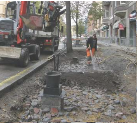
5. incorporation de terre végétale
