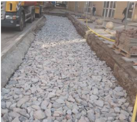
3. couche structurante 90/150 mm
