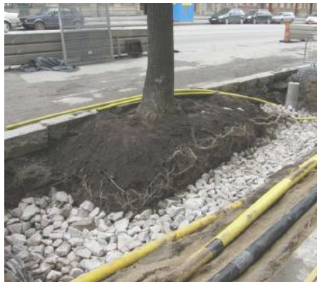
1. préservation des arbres existants
