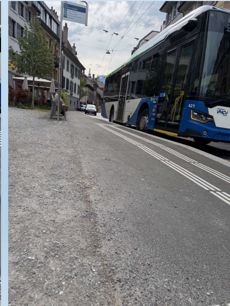
Exemple de transition avec volige
