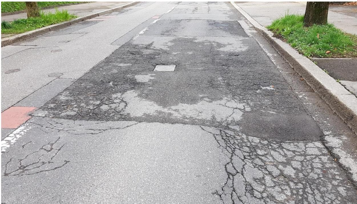
*Dégradation de la chaussée – faïençage et orniérage*
