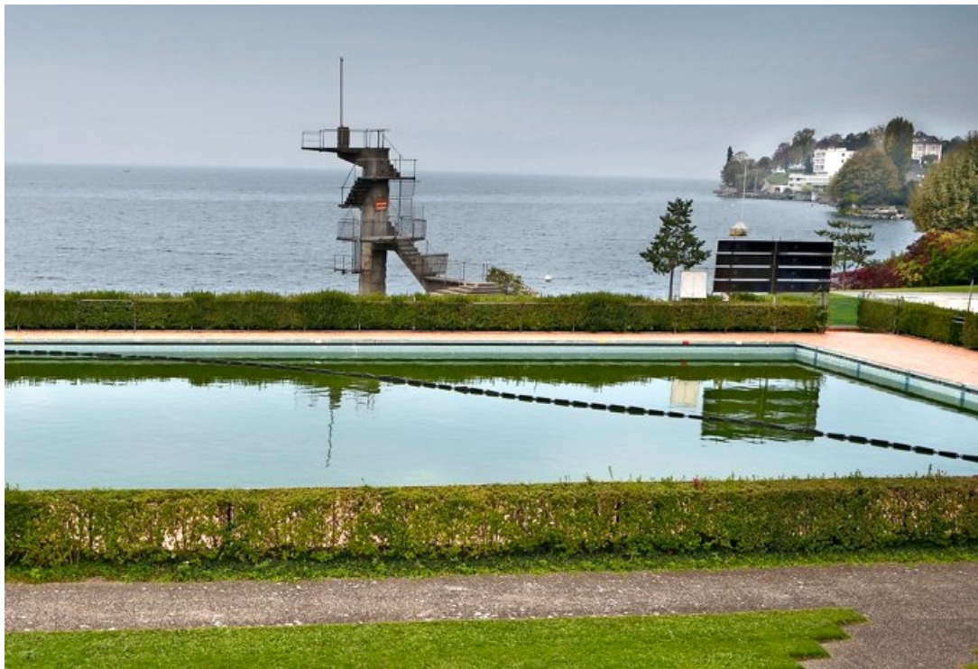
Les installations de Vevey-Corseaux Plage sont à rénover. Mais quand et qui paiera? CHANTAL DERVEY
