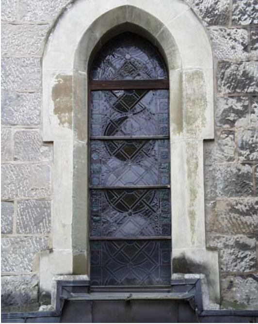
Etat des encadrements et des contreforts en molasse réparés en 1975 par de la molasse dite « synthétique » (parties claires)
