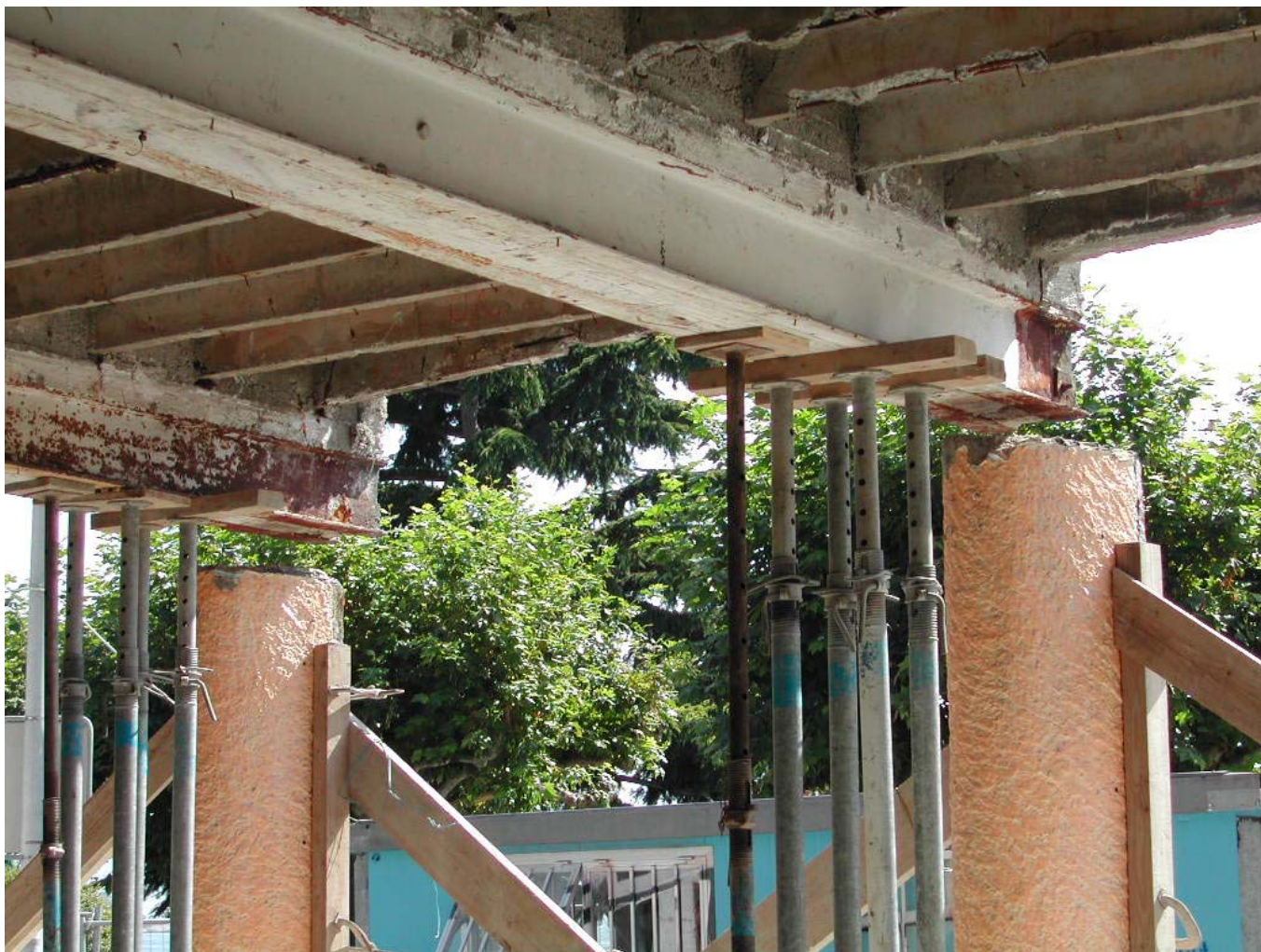
REHABILITATION DES ELEMENTS PORTEURS DE LA FACE SUD
