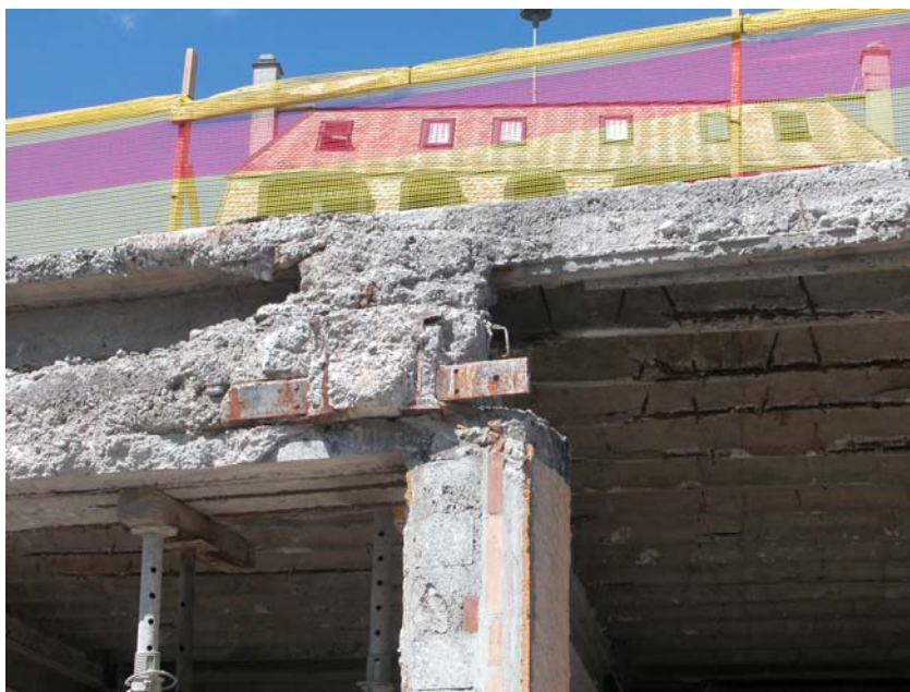
DEMOLITION COMPLETE DU PARAPET DE LA FACADE SUD
