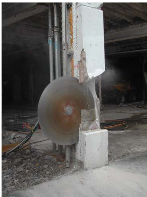
SCIAGE DES ELEMENTS PORTEURS DE LA FACADE
