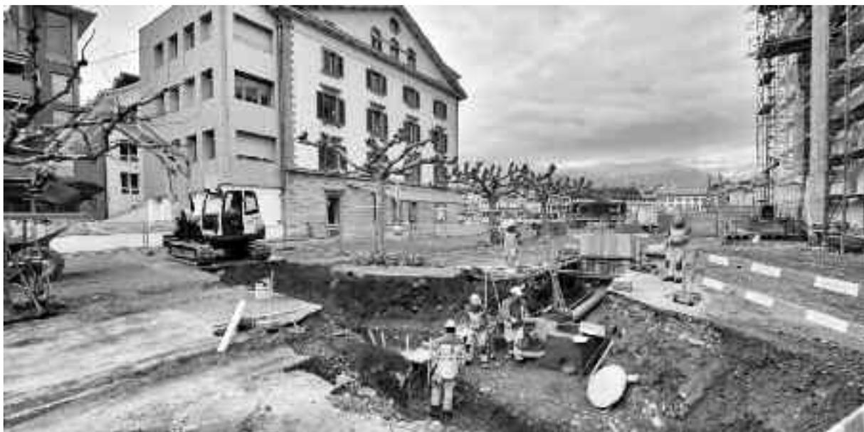
Ces travaux intègrent la poursuite du programme d'introduction du système séparatif, en réalisant l'étape 3 du PALT (Plan à long terme). Dans le cas présent, certains collecteurs centenaires et les réseaux des services industriels nécessitent un remplacement obligatoire.
