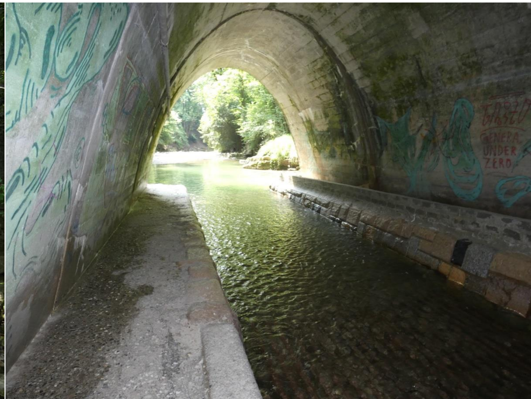
Voûtage des Toveires : Lit de la rivière et portail de Sortie
