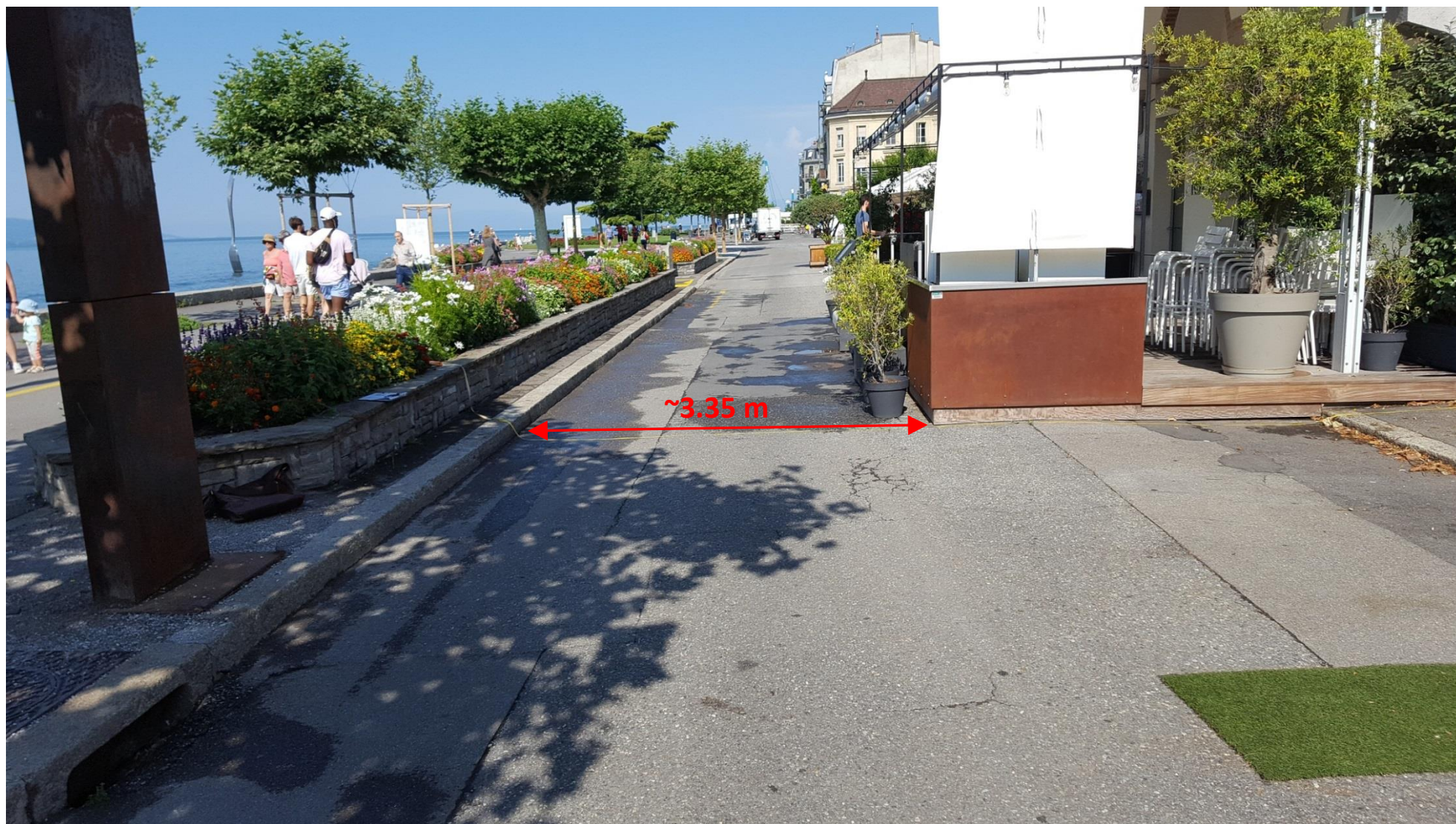
Largeur insuffisante : Suppression des bacs à fleurs, mise à niveau chaussée sur trottoirs
