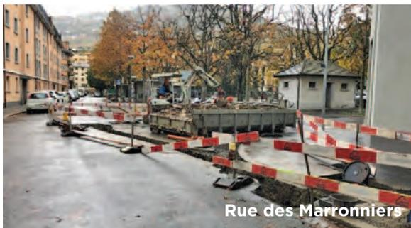
a été constaté au droit du couvercle de la chambre du réseau unitaire datant des années 60. Les travaux ont consisté à poser une nouvelle grille d'évacuation des eaux de chaussée reliée à ladite chambre dont la partie supérieure a été remplacée.
