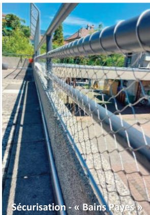
Sécurisation - « Bains Payes »
