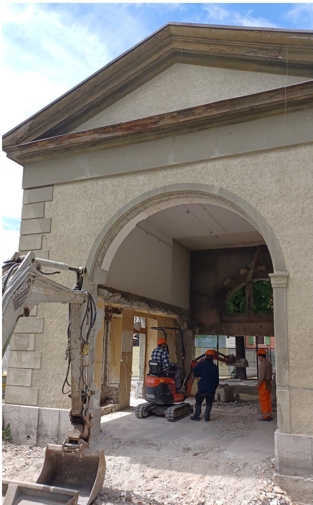
Photo de démolition de l'intérieur du pavillon du 15.05.2024
