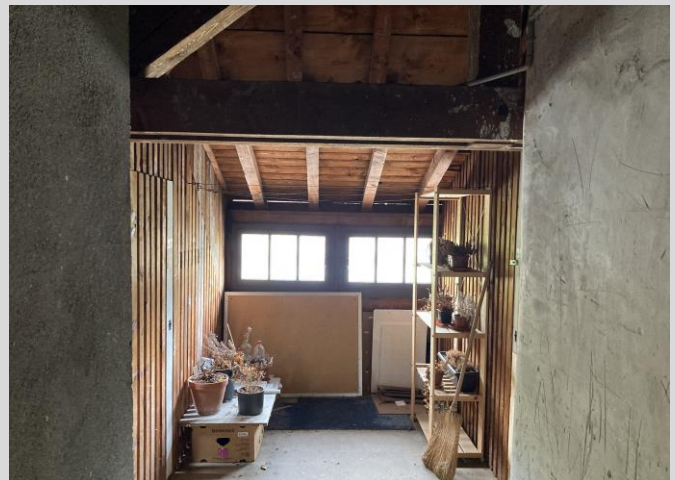
Combles non aménagés
