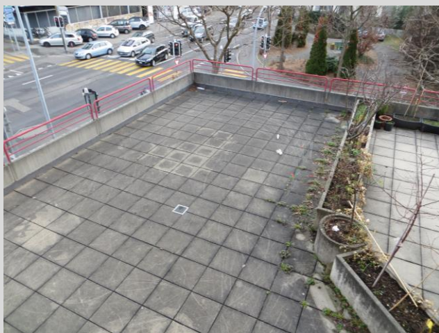
Terrasse côté rue du Clos
