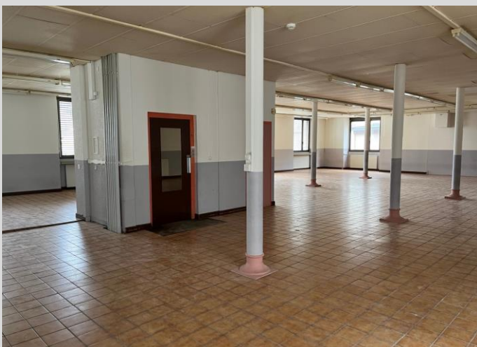
Aménagements intérieurs – colonnes métalliques
