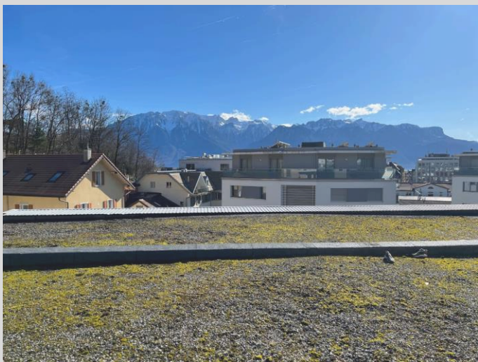
Toiture plate _ sur 4 ème étage
