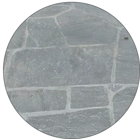
Dallage en joints mortier et finition flammée, accès PMR aux jeux d'eau depuis le chemin des quais
