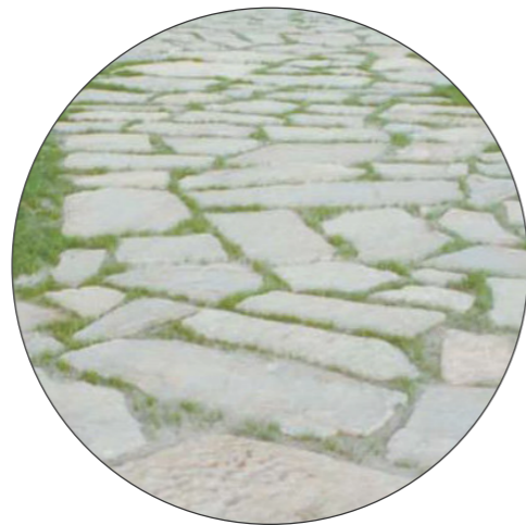
Dallage en joints engazonnés, pourtour des jeux d'eau et de la place de jeux
