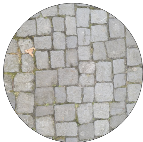
Pavage irrégulier en grès, joints engazonnés, pied du banc circulaire
