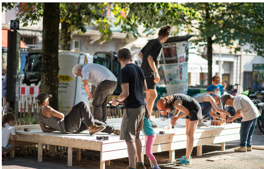
Co-construction de l'aménagement transitoire avec la population
