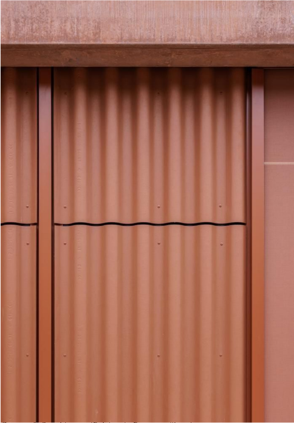
Cuypers & Q architecten (Belgique) - Panneaux fibrociment avec arrêts verticaux en métal
