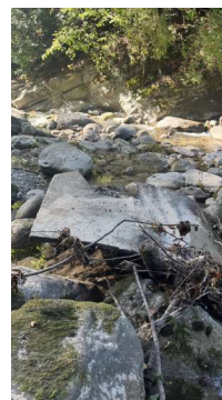
Photo 6 – Éléments métallique et matériaux présents dans le lit du cours d'eau.
