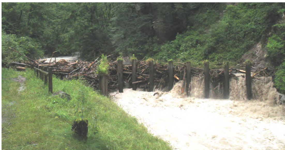
Figure 4 Vue de l'ouvrage de protection (hersch des Toveyres, retenant le bois et les pierres transportés par la Veveyse), lors de la crue de 2007 15 .
