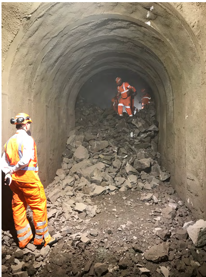
Figure 14 Finalisation du percement du tunnel. (source : Aventron)
