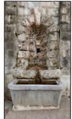
Point de contrôle sur le réseau de distribution, fontaine, Chamby
